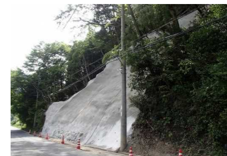
～復旧後～ 【写真提供：和歌山県】
