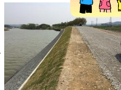
～復旧後～ 【写真提供：兵庫県】
