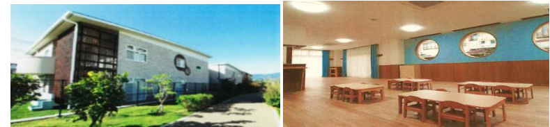
京都府向日市内の保育所(28年2月の定期借地による貸付契約により開所)
