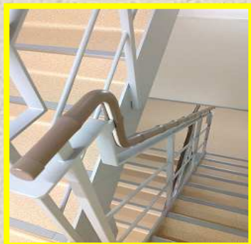
ウェーブ手すり
